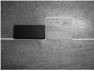
Fig. 7 - Golpee el lateral de la tabla con un bloque para golpear
