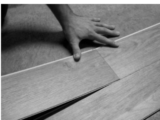
Fig. 5 - Incliner l'extrémité de la planche suivante
