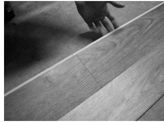
Fig. 6 - Emboîter le long côté avec les extrémités déjà emboîtées
