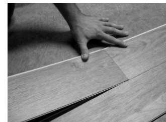
Fig. 5 - Incline el extremo de la siguiente tabla
