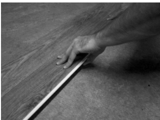
Fig. 4 - Incliner le long côté dans la rangée précédente.
