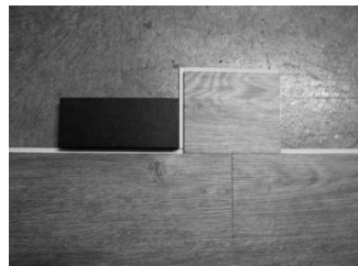
Fig. 7 - Frapper sur le côté de la planche avec un bloc de frappe.
