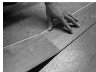
Fig. 3 - Coloque el extremo de la lengüeta dentro de la ranura del extremo de las tablas de la hilera inicial.
